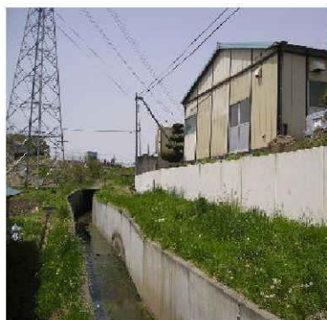
擁壁設置状況 ▼
