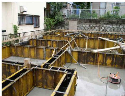
鋼製型枠設置状況
