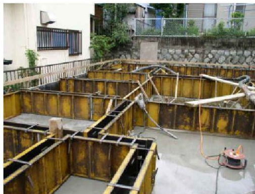
鋼製型枠設置状況
