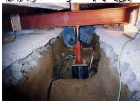
沈下修正・鋼製管圧入状況
