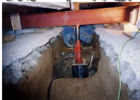
沈下修正・鋼製管圧入状況
